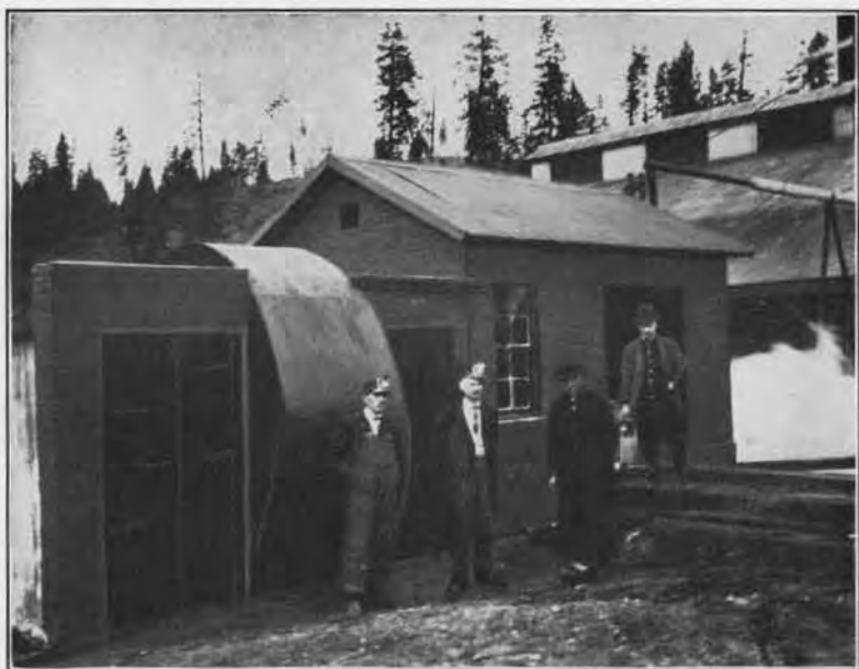
B. Fan House, No. 7 Mine, N. W. I. Co.
