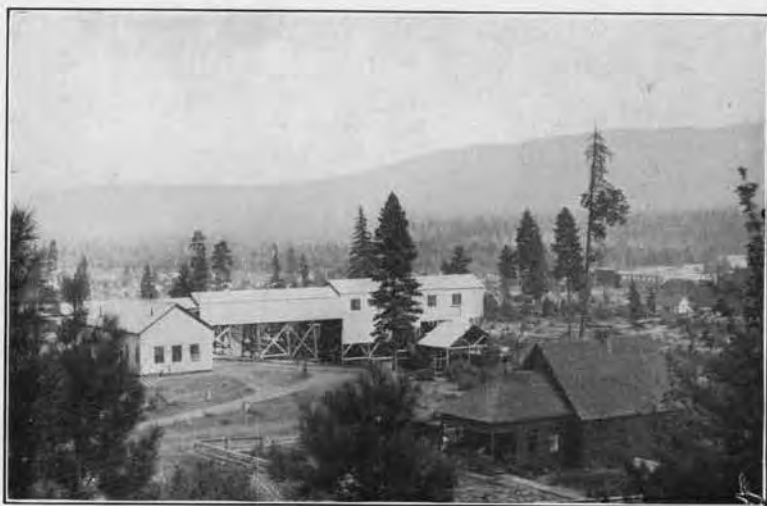
A. Tipple at No. 7 Mine, N. W. I. Co.
